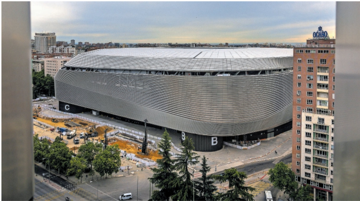
Obras del estadio Santiago Bernabéu desde el paseo de la Castellana, el 25 de abril. SAMUEL SÁNCHEZ
