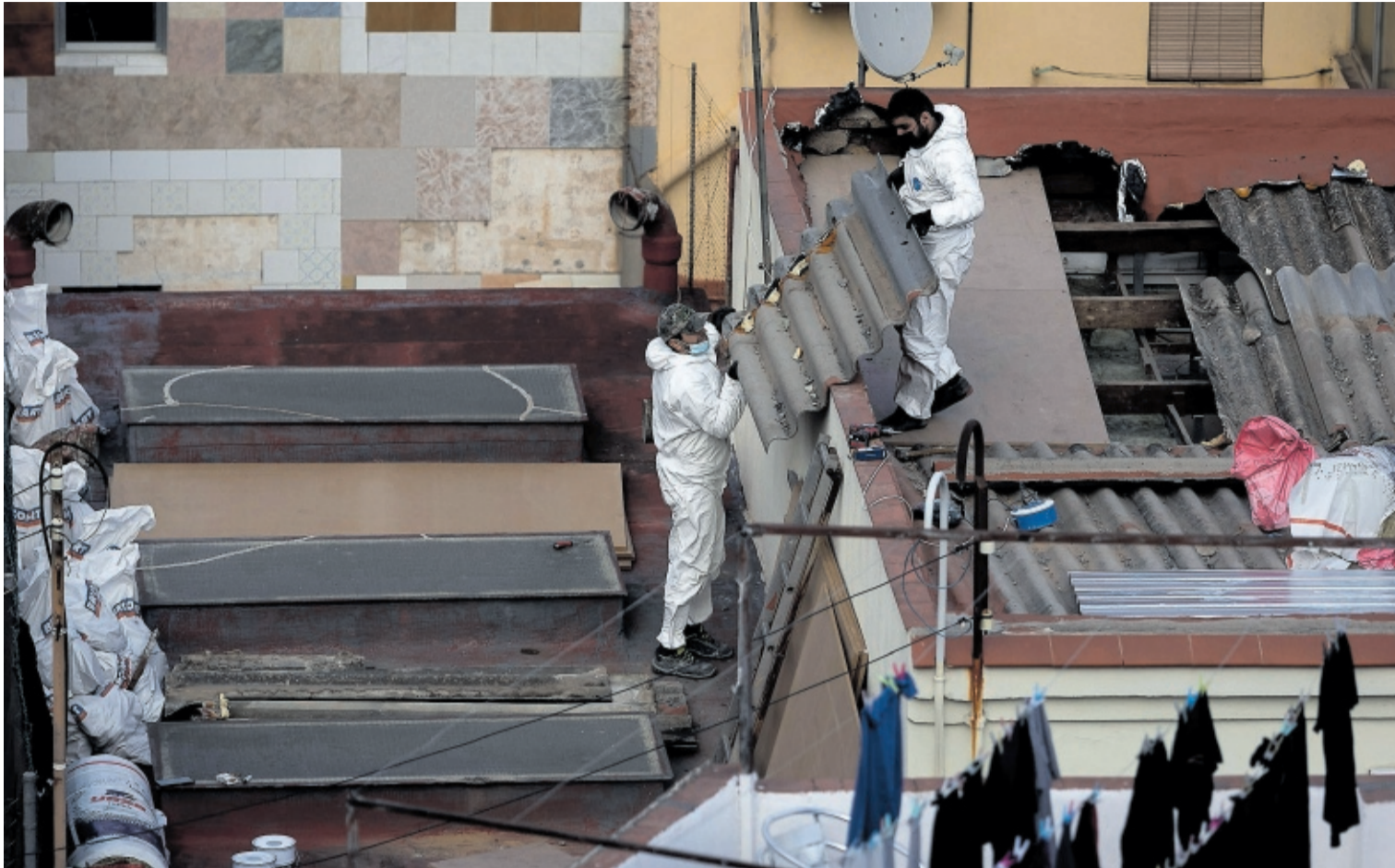
Dos operarios retiran un tejado de amianto en una vivienda en el barrio de Navas, Barcelona, en 2022. ALBERT GARCÍA
